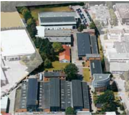
Заводская территория группы «КАЛЬ» с 9 производственными цехами, 4 административными корпусами и столовой
